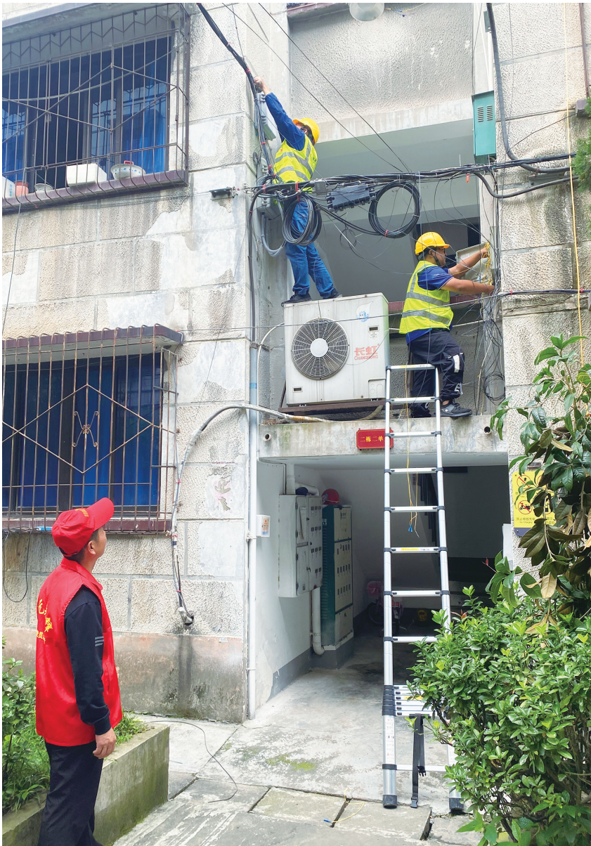
9月26日,市经信局协调移动、联通、电信三家公司,组织专业技术人员前往嘉陵街道凤凰山社区,开展“空中飞线”治理。通过对“空中飞线”进行入地、入管、贴墙、捆扎专项整治,确保走线布局清晰、面貌整洁。
