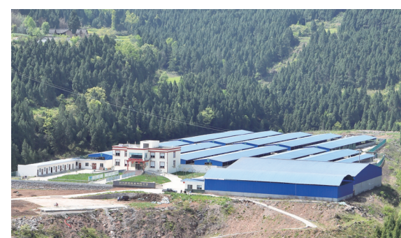
昭化区邱阳牧业养殖园区
